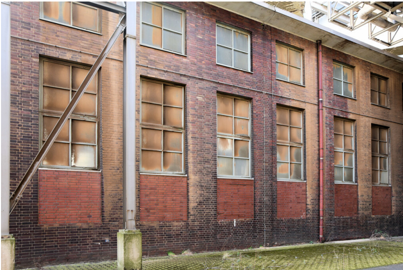
Kraftwerk Frimmersdorf II: Kühlwasser-Pumpenhaus 1, Ansicht von Südosten; Foto: 21.03.2023 Fotograf/Urheber: Dr. Norbert Gilson
