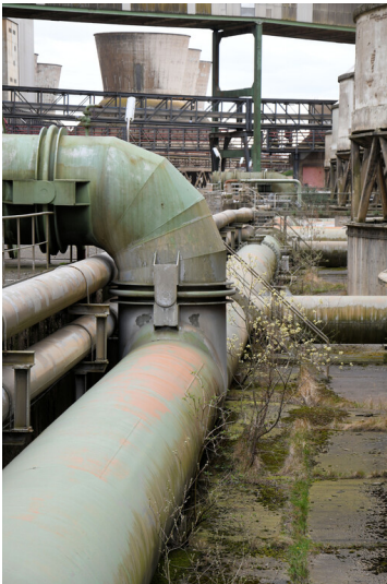
Kraftwerk Frimmersdorf II: Kühlwasserleitungen östlich von Kühlturm 26, Zuführungen in die Kühltürme, Ansicht von Norden; Foto: 22.03.2023 Fotograf/Urheber: Dr. Norbert Gilson
