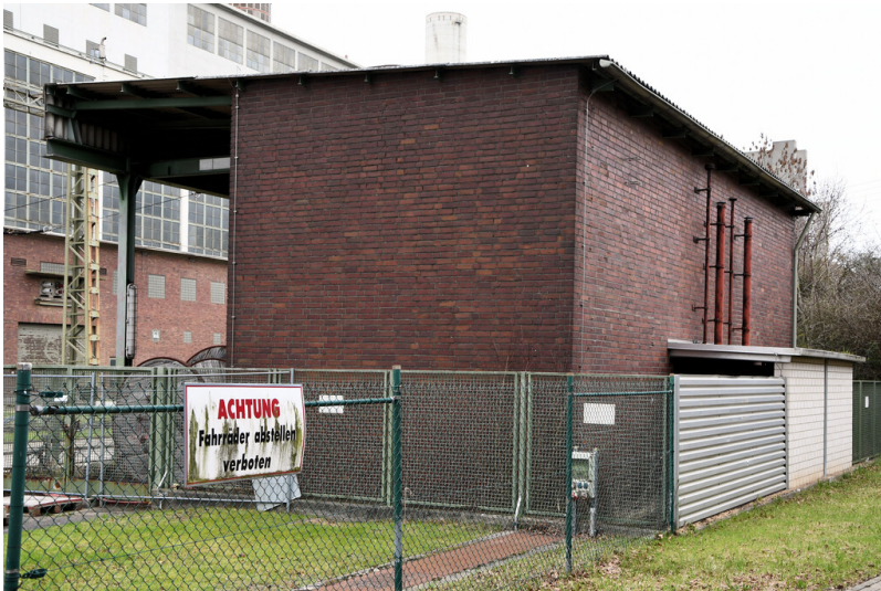
Kraftwerk Frimmersdorf II: ehemalige H2-Anlage, Ansicht von Südosten; Foto: 22.03.2023 Fotograf/Urheber: Dr. Norbert Gilson
