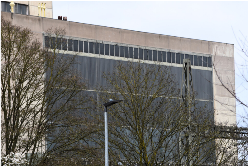
Kraftwerk Frimmersdorf II: Maschinenhaus Block Q, Ansicht von Osten; Foto: 22.03.2023 Fotograf/Urheber: Dr. Norbert Gilson
