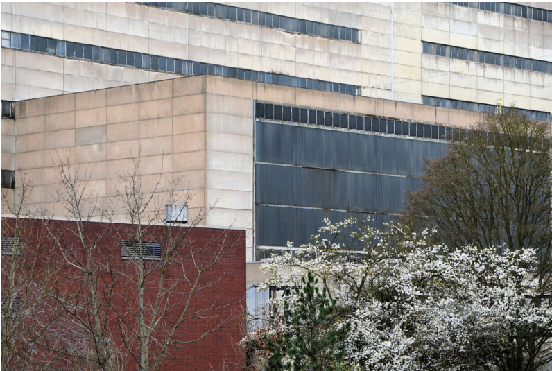
Kraftwerk Frimmersdorf II: Maschinenhaus Block P, Ansicht von Südosten; Foto: 22.03.2023 Fotograf/Urheber: Dr. Norbert Gilson
