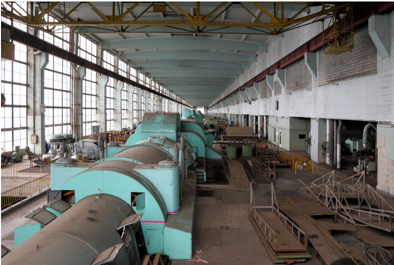
Kraftwerk Frimmersdorf II: Maschinenhaus, Innenansicht von Norden in Richtung Blöcke K/L/M; Foto: 21.03.2023 Fotograf/Urheber: Dr. Norbert Gilson
