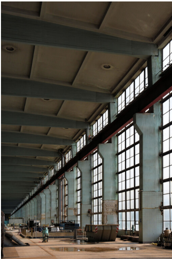
Kraftwerk Frimmersdorf II: Maschinenhaus Blöcke C/D, Konstruktionsdetails Ostseite; Foto: 23.06.2023 Fotograf/Urheber: Dr. Norbert Gilson
