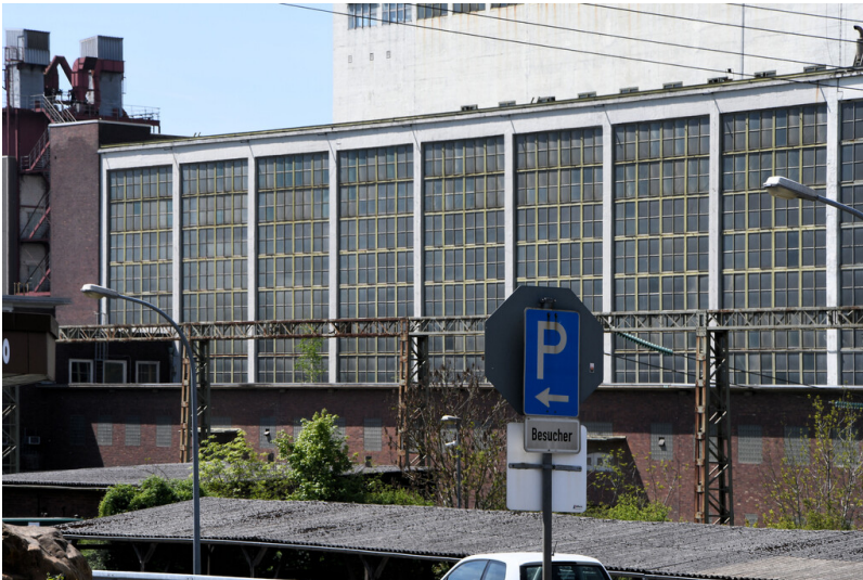
Kraftwerk Frimmersdorf II: Maschinenhaus Blöcke A/B, Ansicht von Osten; Foto: 04.05.2023 Fotograf/Urheber: Dr. Norbert Gilson
