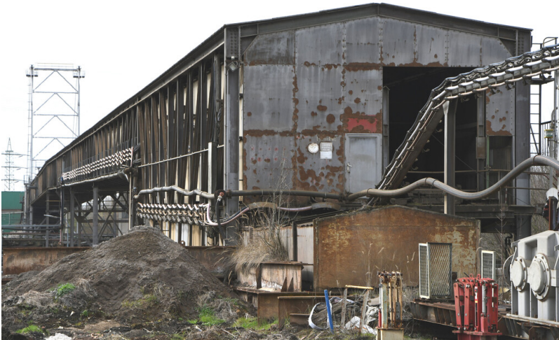
Kraftwerk Frimmersdorf II: Aschefernband zur Kraftwerksrückstandsdeponie Garzweiler, Aufgabestation am Bandanfang, Ansicht von Norden; Foto: 22.03.2023 Fotograf/Urheber: Dr. Norbert Gilson
