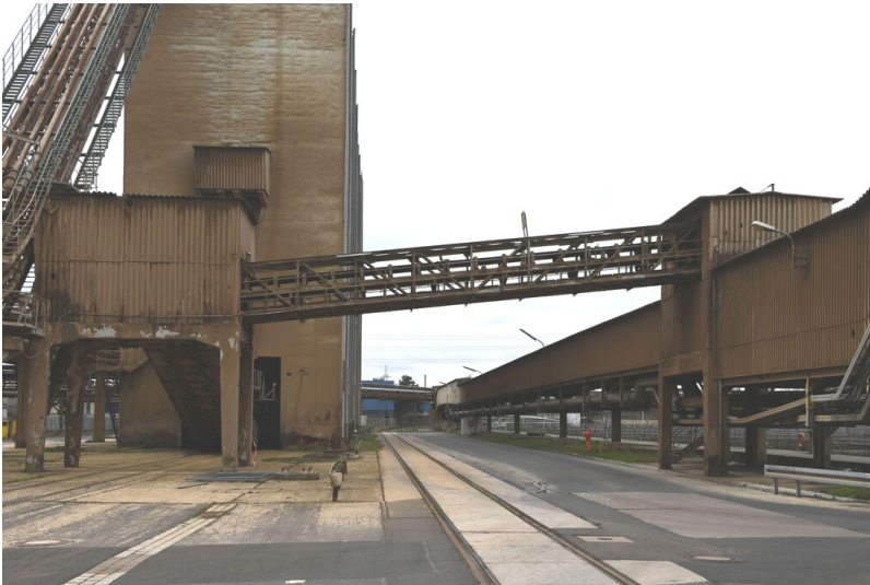
Kraftwerk Frimmersdorf II: Ascheturm 5 (links) mit Aschebandbrücke 6 zu Ascheturm 4, Ansicht von Norden; Foto: 22.03.2023 Fotograf/Urheber: Dr. Norbert Gilson
