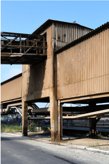
Kraftwerk Frimmersdorf II: Ascheturm 4 im Zuge des Entschungsweges von den Ascheabstzbecken zum Aschefernband, Ansicht von Nordosten; Foto: 23.06.2023 Fotograf/Urheber: Dr. Norbert Gilson
