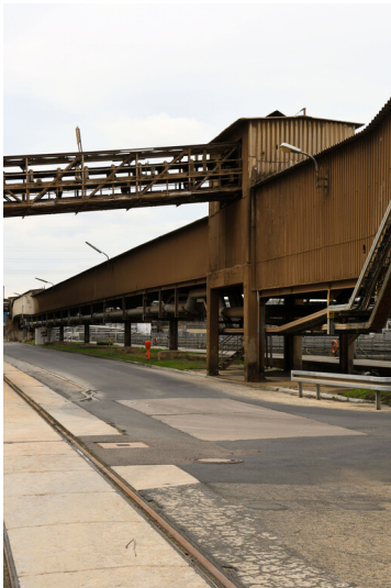
Kraftwerk Frimmersdorf II: Aschebandbrücke am Ascheturm 4, Ansicht von Norden; Foto: 22.03.2023 Fotograf/Urheber: Dr. Norbert Gilson
