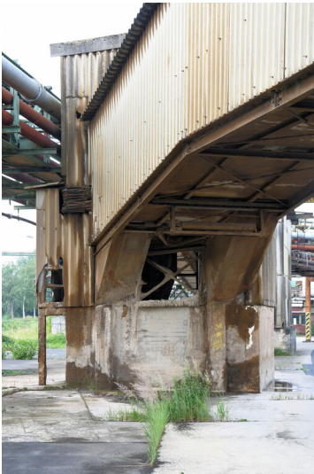
Kraftwerk Frimmersdorf II: Ascheturm 3, Ausgang zur Aschebandbrücke in Richtung Aschefernbahn, Ansicht von Norden; Foto: 23.06.2023 Fotograf/Urheber: Dr. Norbert Gilson
