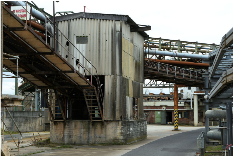
Kraftwerk Frimmersdorf II: Ascheturm 2, Eckturm für Ascheband von den Absetzbecken zum Aschefernbahn, Ansicht von Norden; Foto: 22.03.2023 Fotograf/Urheber: Dr. Norbert Gilson
