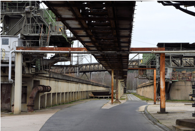
Kraftwerk Frimmersdorf II: Ascheband 1, von den Ascheabsetzbecken zu Ascheturm 2 führend, Ansicht von Nordosten; Foto: 22.03.2023 Fotograf/Urheber: Dr. Norbert Gilson
