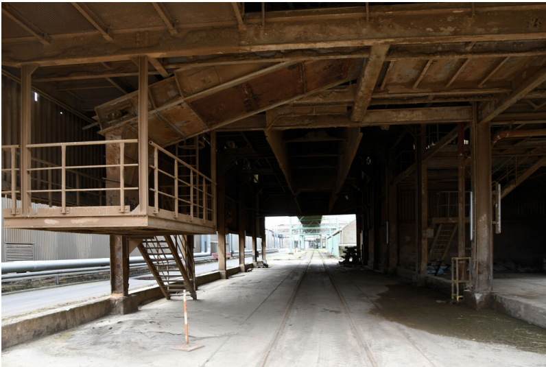
Kraftwerk Frimmersdorf II: Werkgleis in der Asche-Waggonverladung, Ansicht von Süden; Foto: 22.03.2023 Fotograf/Urheber: Dr. Norbert Gilson
