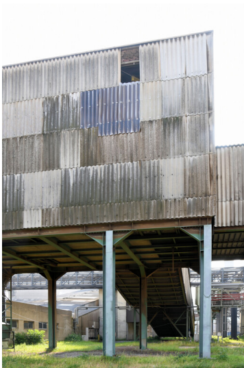
Kraftwerk Frimmersdorf II: Ascheturm 7, Ansicht von Westen; Foto: 22.03.2023 Fotograf/Urheber: Dr. Norbert Gilson
