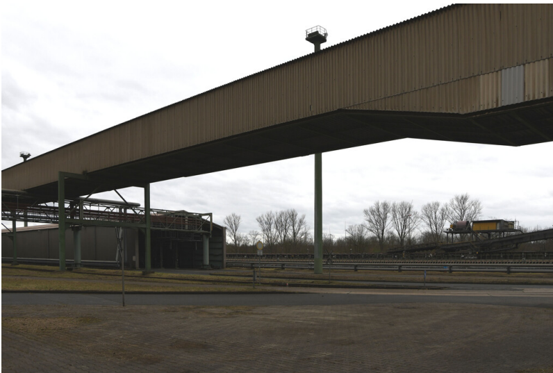
Kraftwerk Frimmersdorf II: Entaschung Blöcke P/Q, Aschebandbrücke zur Asche-Waggonverladung, Ansicht von Nordosten; Foto: 22.03.2023 Fotograf/Urheber: Dr. Norbert Gilson
