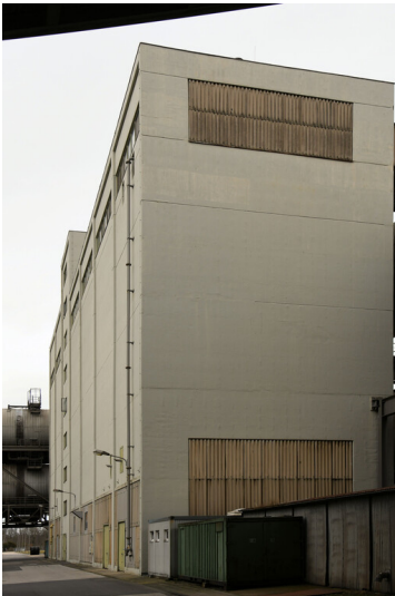
Kraftwerk Frimmersdorf II: Aschehochbunker für die Blöcke P/Q, Ansicht von Süden; Foto: 22.03.2023 Fotograf/Urheber: Dr. Norbert Gilson
