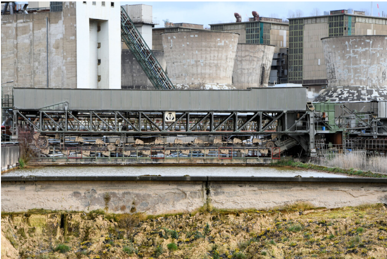
Kraftwerk Frimmersdorf II: Aschebagger 2 im Ascheabsetzbecken 2, Ansicht von Südwesten; Foto: 22.03.2023 Fotograf/Urheber: Dr. Norbert Gilson
