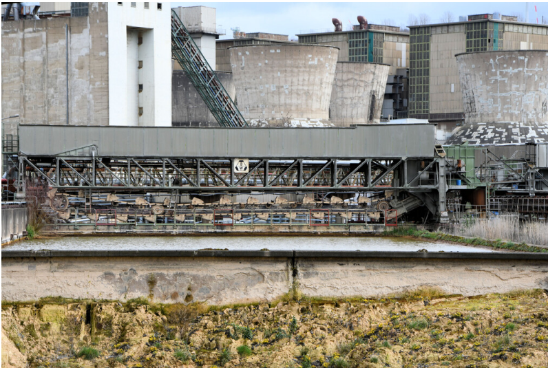
Kraftwerk Frimmersdorf II: Aschebagger 2 im Ascheabsetzbecken 2, Ansicht von Südwesten; Foto: 22.03.2023 Fotograf/Urheber: Dr. Norbert Gilson
