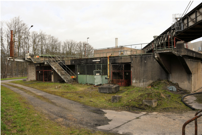
Kraftwerk Frimmersdorf II: Ascheabsetzbecken 2, Ansicht von Süden; Foto: 22.03.2023 Fotograf/Urheber: -
