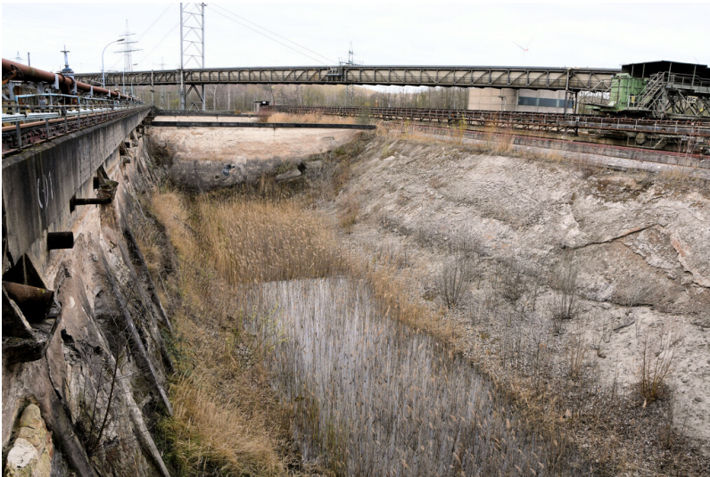
Kraftwerk Frimmersdorf II: Ascheabsetzbecken 1 (Kammern I bis III), Ansicht von Nordosten; Foto: 22.03.2023 Fotograf/Urheber: Dr. Norbert Gilson
