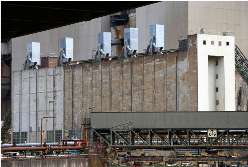
Kraftwerk Frimmersdorf II: Aschehochbunker für die Blöcke A bis O, Ansicht von Südwesten; Foto: 22.03.2023 Fotograf/Urheber: Dr. Norbert Gilson
