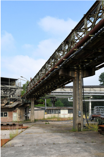
Kraftwerk Frimmersdorf II: Rohrbrücke zur Führung der Rohre für die hydraulische Ascheförderung zu Ascheabsetzbecken 2, Ansicht von Osten; Foto: 23.06.2023 Fotograf/Urheber: Dr. Norbert Gilson
