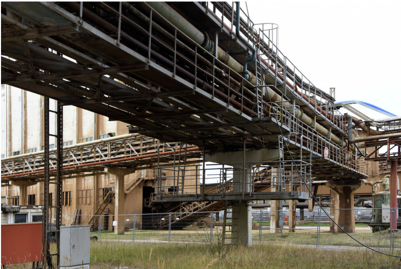
Kraftwerk Frimmersdorf II: Rohrbrücke von den Blöcken F/O zum Aschehochbunker und zu den Ascheabsetzbecken, Ansicht von Nordosten; Foto: 22.03.2023 Fotograf/Urheber: Dr. Norbert Gilson
