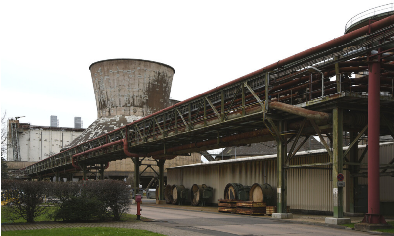
Kraftwerk Frimmersdorf II: Rohrbrücke zwischen dem Kesselhaus Block A und dem Aschehochbunker A/O, Ansicht von Südosten; Foto: 22.03.2023 Fotograf/Urheber: Dr. Norbert Gilson
