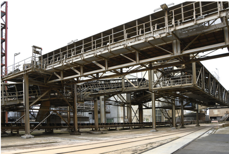
Kraftwerk Frimmersdorf II: Gipsverladung auf Zug, Ansicht von Südosten; Foto: 22.03.2023 Fotograf/Urheber: Dr. Norbert Gilson
