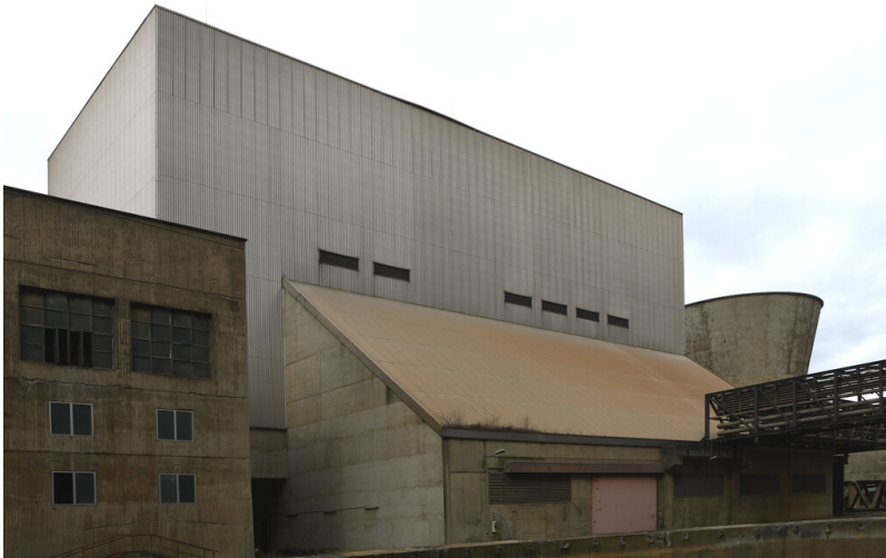
Kraftwerk Frimmersdorf II: Gipsbunker, Ansicht von Südosten; Foto: 22.03.2023 Fotograf/Urheber: Dr. Norbert Gilson
