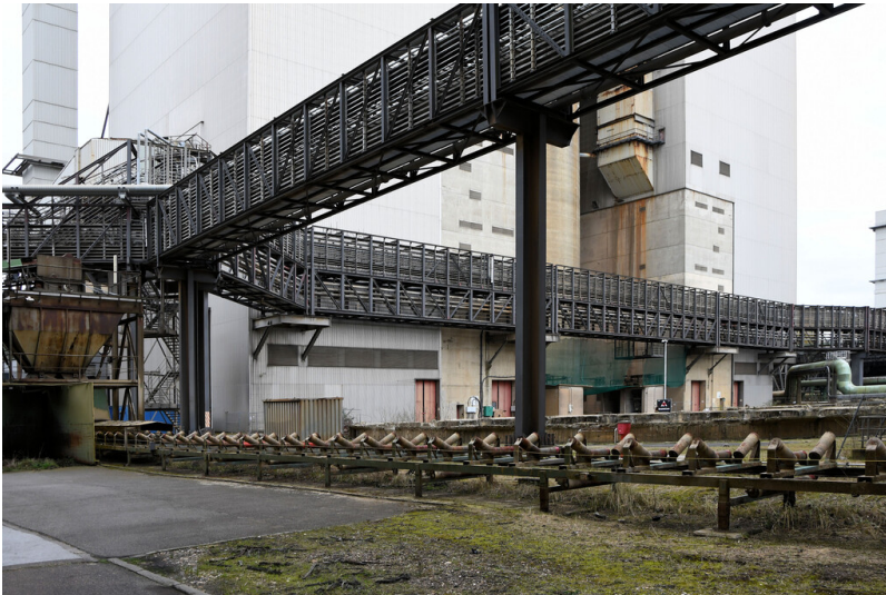
Kraftwerk Frimmersdorf II: Rohrbrücken für Kalk- und Gipstransport, vor den REA-Wäschergebäuden N/O und L/M, Ansicht von Norden; Foto: 22.03.2023 Fotograf/Urheber: Dr. Norbert Gilson
