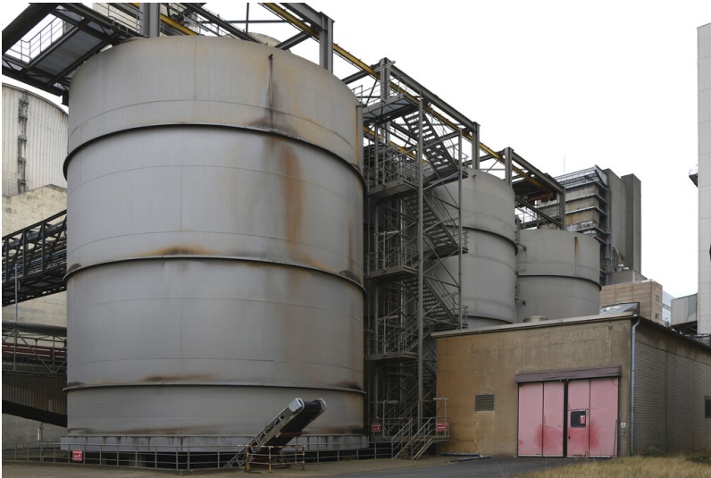
Kraftwerk Frimmersdorf II: Auffangbehälter für den Fall einer Störung in der REA der Blöcke P/Q, Ansicht von Westen; Foto: 22.03.2023 Fotograf/Urheber: Dr. Norbert Gilson
