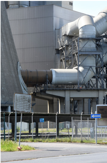
Kraftwerk Frimmersdorf II: Rauchgasreinigung, Reingaseinleitung in Naturzug-Kühlturm Block Q, Ansicht von Norden; Foto: 04.05.2023 Fotograf/Urheber: Dr. Norbert Gilson
