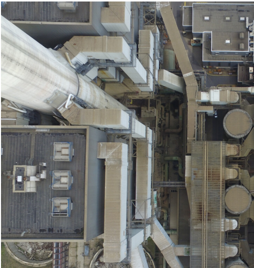
Kraftwerk Frimmersdorf II: Reingaseinleitungen in REA-Kamin 3, Ansicht Drohnenüberflug-Foto; Foto: Juli 2017 Fotograf/Urheber: RWE Power AG
