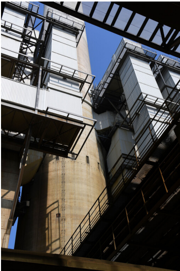
Kraftwerk Frimmersdorf II: Reingaseinleitung in REA-Kamin 1, rechts von Wäschergebäudeteil E/F, Ansicht von Südosten; Foto: 23.06.2023 Fotograf/Urheber: Dr. Norbert Gilson
