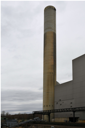
Kraftwerk Frimmersdorf II: REA-Kamin für Block P (auch Bypass-Kamin für Block Q), Ansicht von Südwesten; Foto: 22.03.2023 Fotograf/Urheber: Dr. Norbert Gilson
