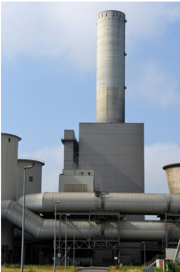
Kraftwerk Frimmersdorf II: REA-Kamin 3, Wäschergebäude N/O, Ansicht von Norden; Foto: 23.06.2023 Fotograf/Urheber: Dr. Norbert Gilson
