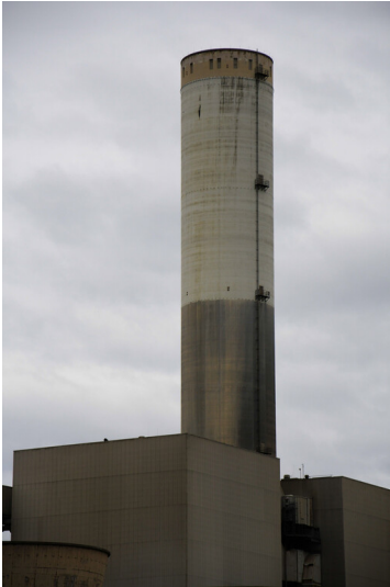
Kraftwerk Frimmersdorf II: REA-Kamin 2 für die Blöcke G/H und J/K, Ansicht von Norden; Foto: 22.03.2023 Fotograf/Urheber: Dr. Norbert Gilson
