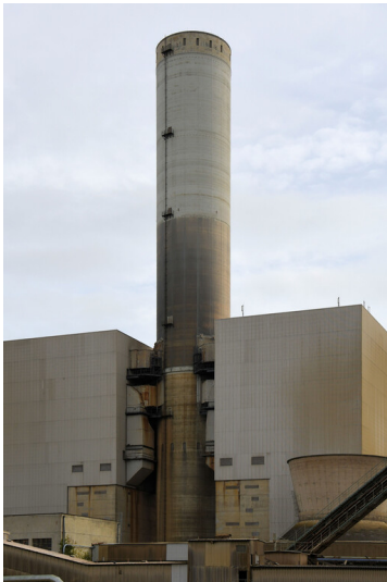
Kraftwerk Frimmersdorf II: REA-Kamin 1 für die REA-Anlagen der Blöcke C/D und E/F, Ansicht von Westen; Foto: 22.03.2023 Fotograf/Urheber: Dr. Norbert Gilson
