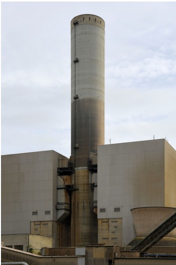
Kraftwerk Frimmersdorf II: REA-Kamin 1 für die REA-Anlagen der Blöcke C/D und E/F, Ansicht von Westen; Foto: 22.03.2023 Fotograf/Urheber: Dr. Norbert Gilson
