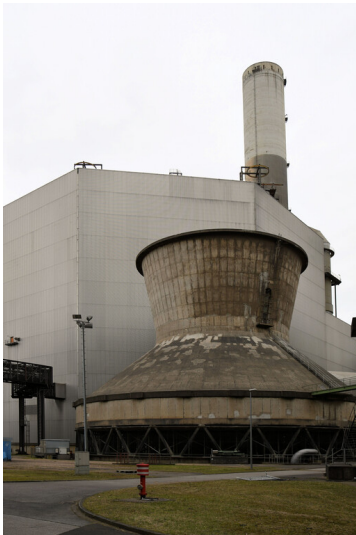
Kraftwerk Frimmersdorf II: REA-Wäschergebäude für die Blöcke P/Q, davor Ventilator-Kühlturm P2, Ansicht von Südosten; Foto: 22.03.2023 Fotograf/Urheber: Dr. Norbert Gilson
