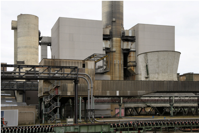
Kraftwerk Frimmersdorf II: REA-Wäschergebäude L/M (rechts) und N/O (links), Ansicht von Nordwesten; Foto: 22.03.2023 Fotograf/Urheber: Dr. Norbert Gilson
