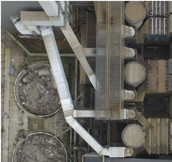
Kraftwerk Frimmersdorf II: Rohgaskanäle Blöcke L (unten) und M (Mitte), Einleitung ins Wäschergebäude L/M, Ansicht Drohnenüberflug-Foto; Foto: Juli 2017 Fotograf/Urheber: RWE Power AG
