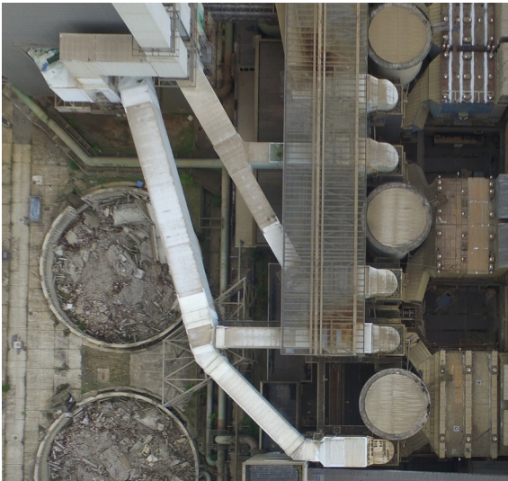
Kraftwerk Frimmersdorf II: Rohgaskanäle Blöcke L (unten) und M (Mitte), Einleitung ins Wäschergebäude L/M, Ansicht Drohnenüberflug-Foto; Foto: Juli 2017 Fotograf/Urheber: RWE Power AG
