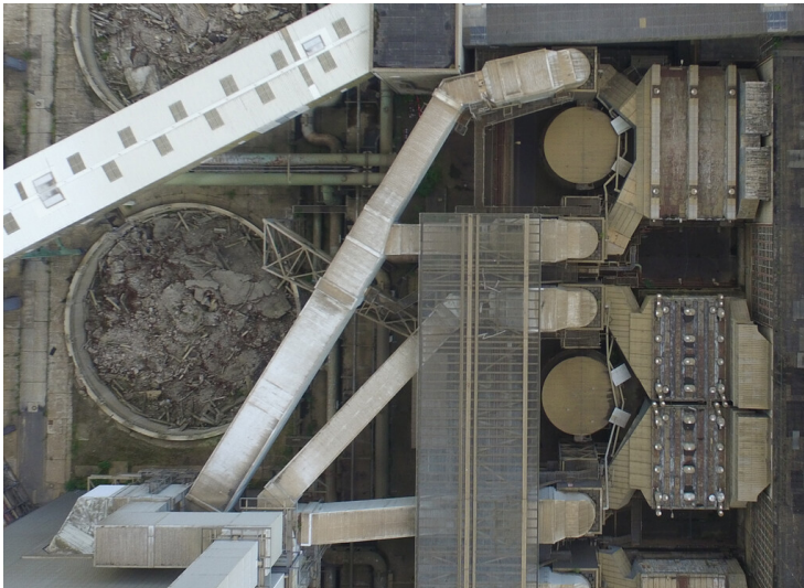
Kraftwerk Frimmersdorf II: Rohgaskanäle Blöcke J (unten) und K (oben), Einleitung ins Wäschergebäude J/K, Ansicht Drohnenüberflug-Foto; Foto: Juli 2017 Fotograf/Urheber: RWE Power AG
