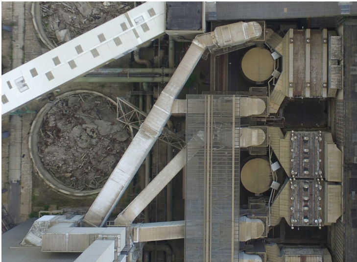
Kraftwerk Frimmersdorf II: Rohgaskanäle Blöcke J (unten) und K (oben), Einleitung ins Wäschergebäude J/K, Ansicht Drohnenüberflug-Foto; Foto: Juli 2017 Fotograf/Urheber: RWE Power AG
