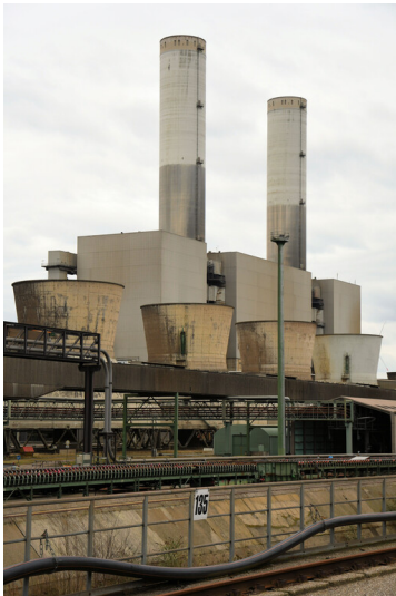
Kraftwerk Frimmersdorf II: REA-Wäschergebäude für die Blöcke E/F und G/H (Mitte), Ansicht von Nordwesten; Foto: 22.03.2023 Fotograf/Urheber: Dr. Norbert Gilson
