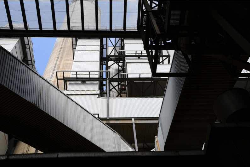
Kraftwerk Frimmersdorf II: Rohgaskanäle Blöcke E und F vor Kamin 1 und Wäschergebäude E/F/G/H, Ansicht von Osten; Foto: 23.06.2023 Fotograf/Urheber: Dr. Norbert Gilson
