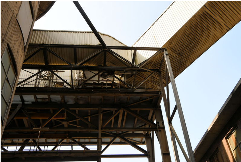
Kraftwerk Frimmersdorf II: Rohgaskanal Block C, Ansicht von Norden; Foto: 23.06.2023 Fotograf/Urheber: Dr. Norbert Gilson
