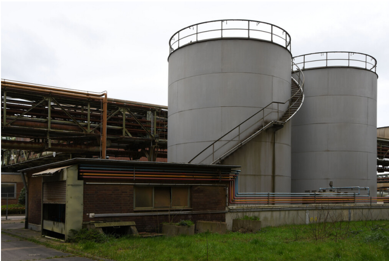
Kraftwerk Frimmersdorf II: Zündölanlage, Zündöltanks, Ansicht von Nordosten; Foto: 22.03.2023 Fotograf/Urheber: Dr. Norbert Gilson
