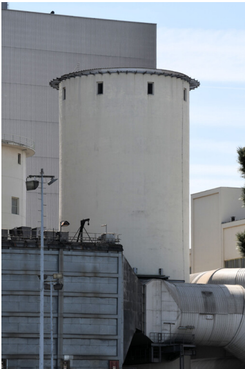
Kraftwerk Frimmersdorf II: Rauchgasreinigung, Schornstein-Fundamentsockel Block Q, Ansicht von Norden; Foto: 04.05.2023 Fotograf/Urheber: Dr. Norbert Gilson
