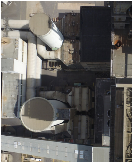
Kraftwerk Frimmersdorf II: Elektrofilter Block Q (im Bild oben, unten E-Filter Block P), Ansicht Drohnenüberflug-Foto; Foto: Juli 2017 Fotograf/Urheber: RWE Power AG
