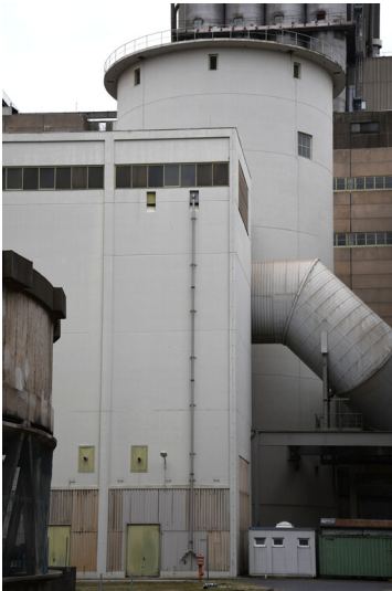
Kraftwerk Frimmersdorf II: Schornstein-Fundamentsockel von Block P, davor Rohgasrohr Block P und Aschehochbunker P/Q, Ansicht von Westen; Foto: 22.03.2023 Fotograf/Urheber: Dr. Norbert Gilson
