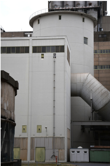
Kraftwerk Frimmersdorf II: Schornstein-Fundamentsockel von Block P, davor Rohgasrohr Block P und Aschehochbunker P/Q, Ansicht von Westen; Foto: 22.03.2023 Fotograf/Urheber: Dr. Norbert Gilson
