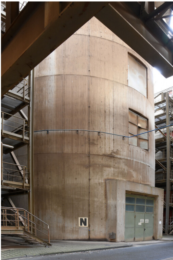
Kraftwerk Frimmersdorf II: Schornstein-Fundamentsockel Block N, Ansicht von Nordwesten; Foto: 21.03.2023 Fotograf/Urheber: Dr. Norbert Gilson
